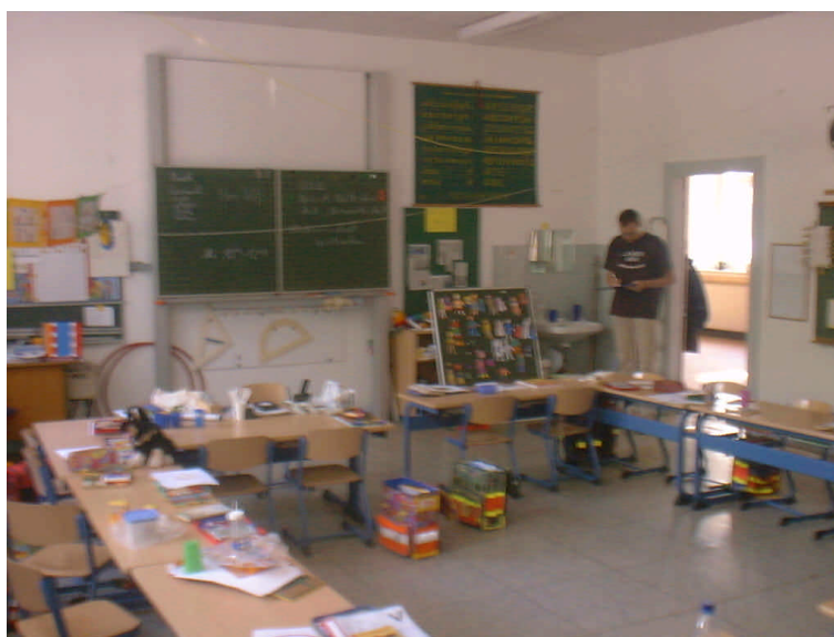
Abbildung 2: Innenansicht eines Klassenraumes, 1. Stock Altbau
