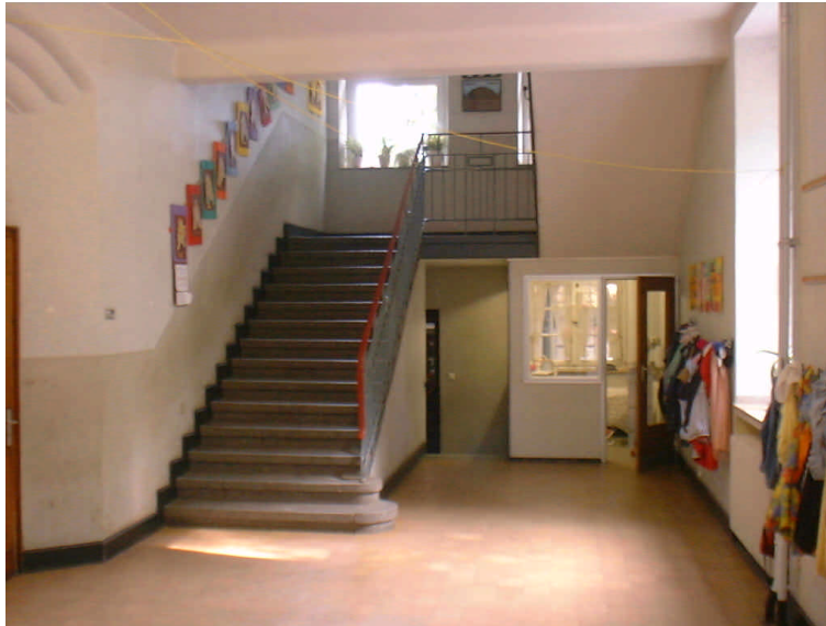
Abbildung 9: Treppe im Altbau.
